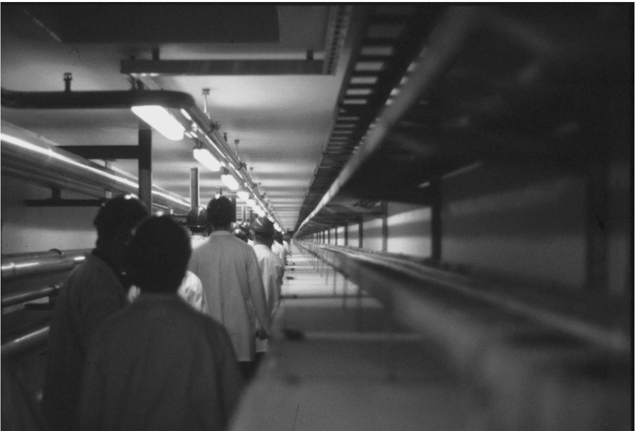
Tämän 100-metrisen käytävän päässä on Olkiluodon ydinpolttoainevarasto
