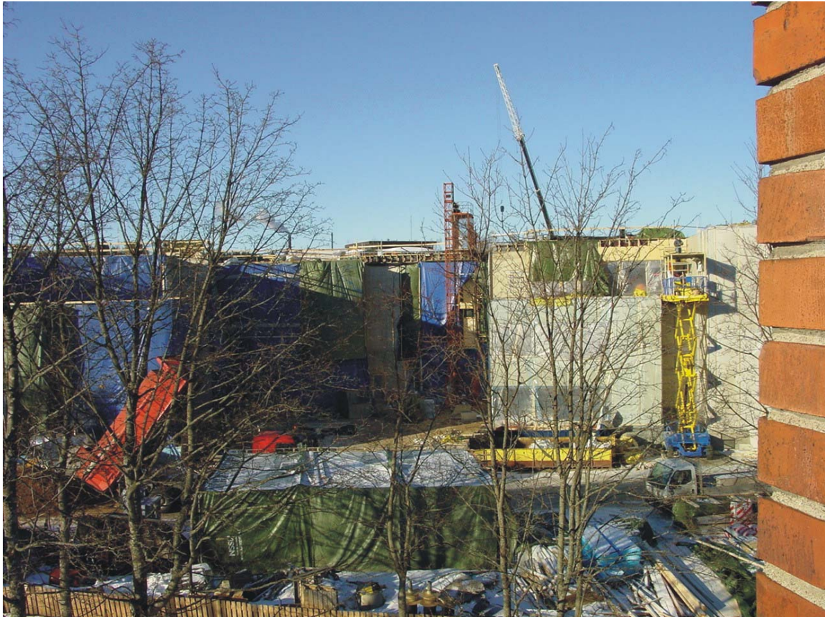
14.2.2002. Kampuksen puolelta työmaa näyttää tältä.
