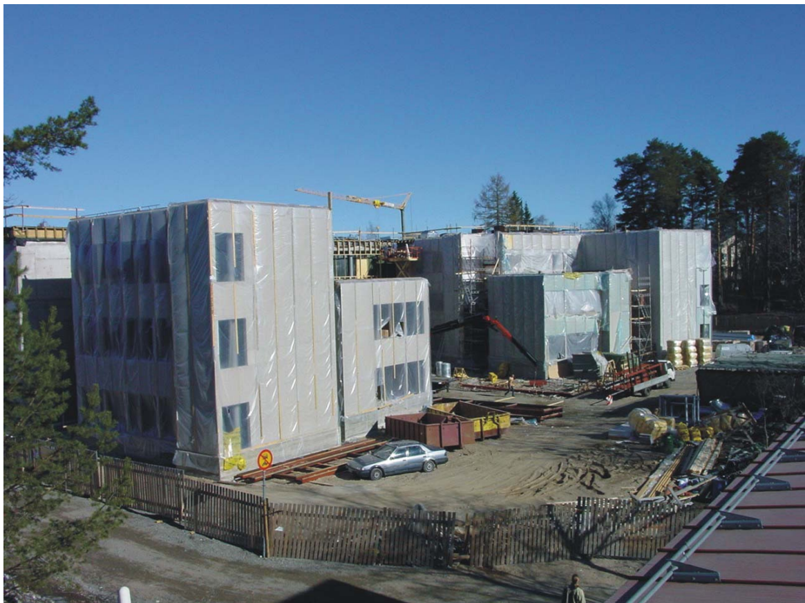
24.4.2002. Tässä yleisnäkymä U-rakennuksen katolta.
